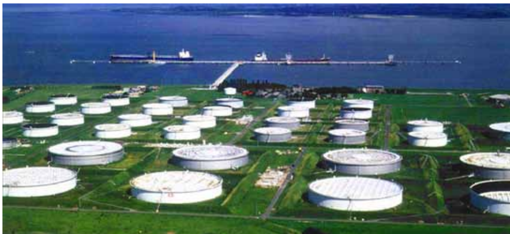
Рис. 1. Резервуарный парк хранения СУГ
