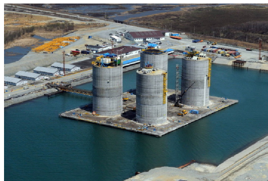
Рис. 2. Док заполненный водой
