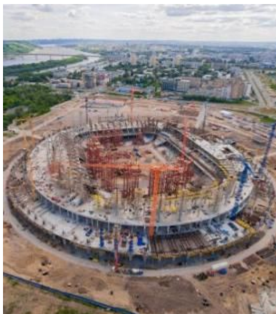
Рисунок 1 – Строительство стадиона в районе ул. Стрелка
