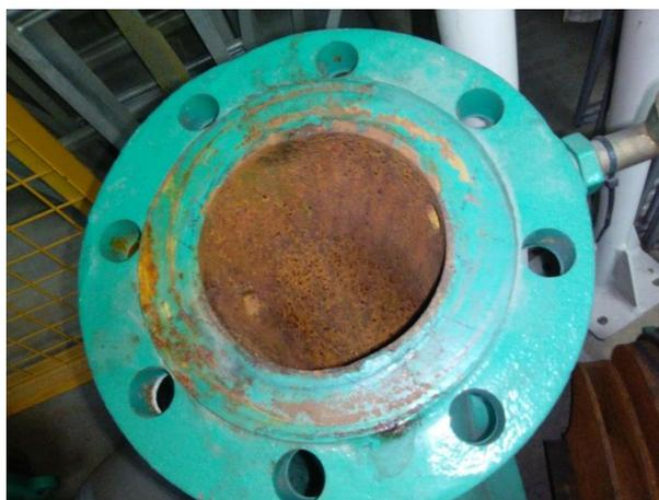
Рис.3 Патрубок насоса, покрытый коррозией
