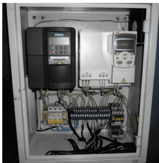
Рис. 9. Установленные преобразователи частоты
