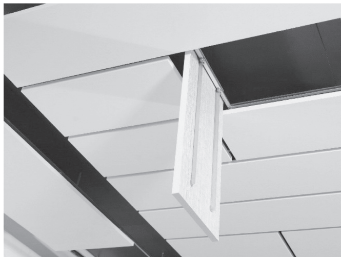
Рис. 4. Акустическая потолочная система Ecorphon
