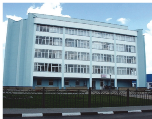
Рис. 4. Терапевтический корпус Новооскольской ЦРБ (2005 г.)
