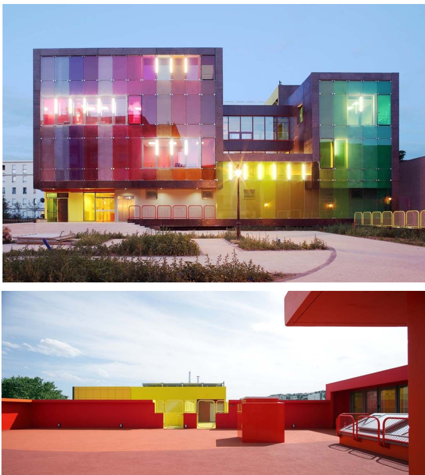
Рис.4– Детский досуговый центр в Сэн-Клу, Франция, KOZ Architectes, [10]
