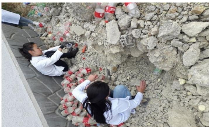
Рисунок 3 – Измельчение и заполнение ПЭТ-бутылок сероперлитсодержащим производственным отходом «СКЗ-У»
