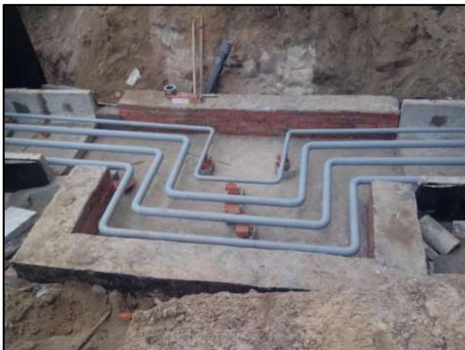
Рис 1. П-образный компенсатор на участке тепловой сети. Антикоррозийная обработка.
