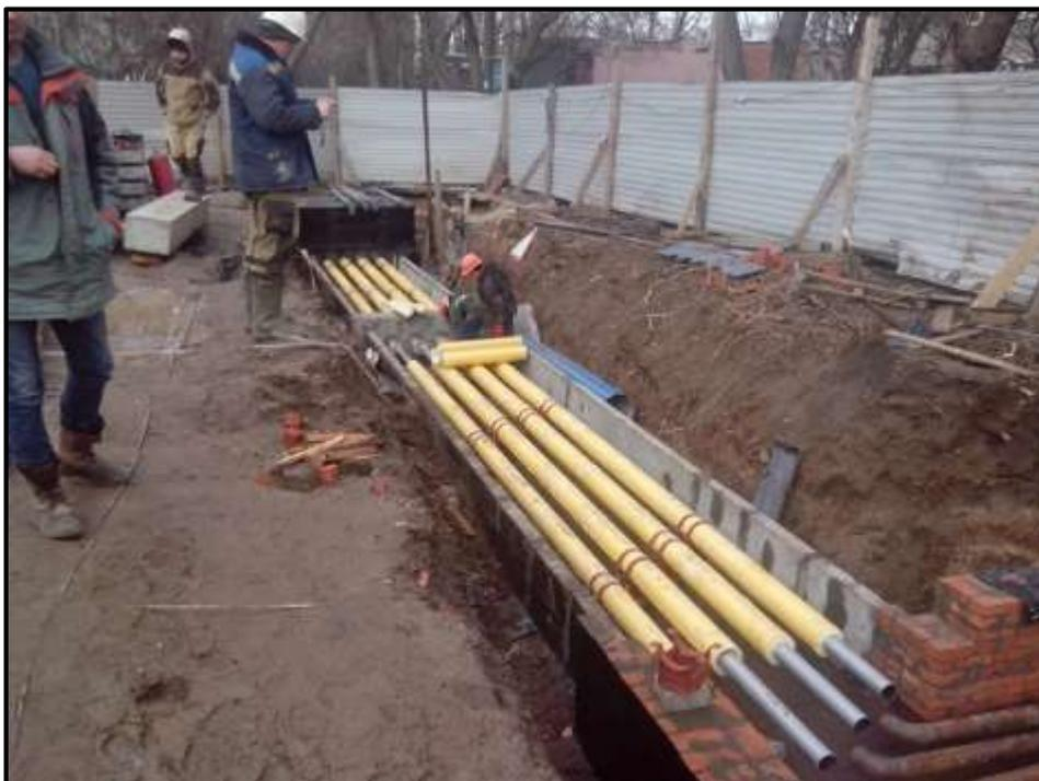
Рис 4. Участок тепловой сети смонтированный с применением ППМ.
