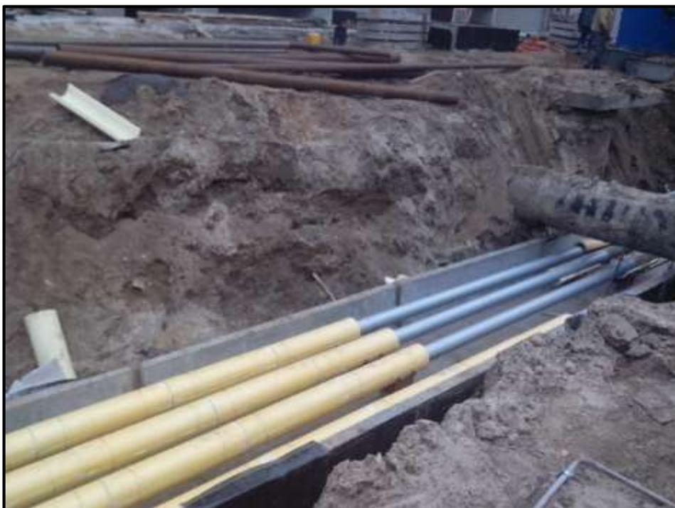
Рис 3. Участок тепловой сети подготовленный для тепловой изоляции ППМ.
